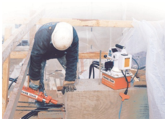
PE60-Pumpe im Einsatz bei Spannarbeiten.
