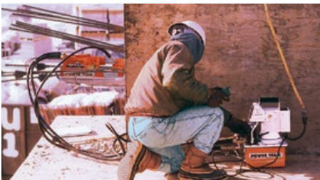
PE60-Pumpe im Einsatz bei Spannarbeiten.
